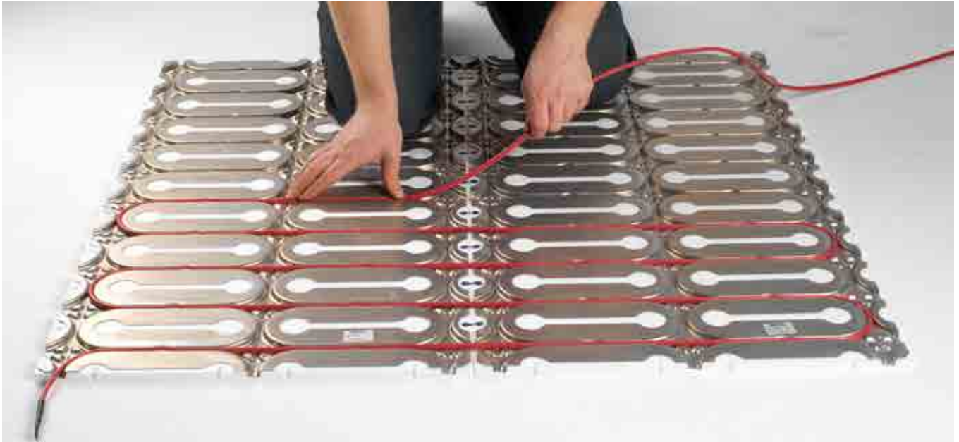
Fig. 20. Montagemetode for varmekabel i DEVIcell™
