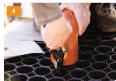
4: Tilløbet afmærkes på siden eller ovenpå faskinen ved at skære fri ind i BIO-BLOK® elementet med saks eller hobbykniv. Ved sideindføring skæres yderligere ca. 10 cm væk foran tilløbets munding.
