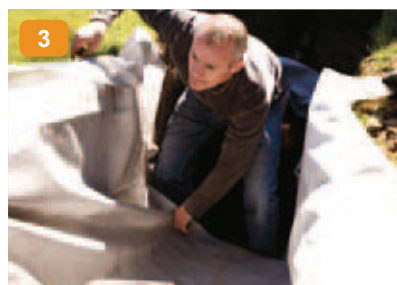
3: Fiberdugen lægges ud i bunden af udgravningen på plant underlag. Placer BIO-BLOK® elementerne med lodret stående rør. Undgå så vidt muligt jord m.m. på dugen.
