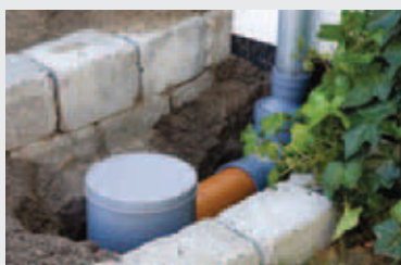
5: Tilløbsrøret monteres igen, og fiberdugen pakkes nu HELT tæt omkring BIO-BLOK® elementerne og regnvandsledningen, så jord m.m. ikke kan trænge ind i faskinen.
