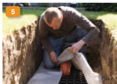
5: Tilløbsrøret monteres igen, og fiberdugen pakkes nu HELT tæt omkring BIO-BLOK® elementerne og regnvandsledningen, så jord m.m. ikke kan trænge ind i faskinen.
