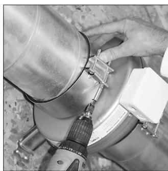
3. Spän fast montage-klammer på vardera sida om fläkten med skruvorna.
