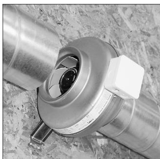
2. Rohre und Ventilator zusammensetzen.
